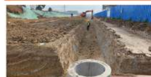
EXCAVACIÓN EN ZANJAS
