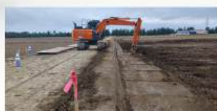
CONSTRUCCIÓN DE CARRETERAS
