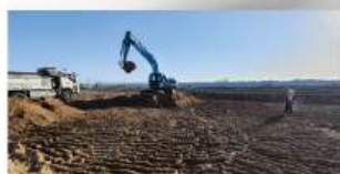
NIVELACIÓN DEL TERRENO
