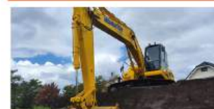
CONSTRUCCIÓN DE TALUDES Y EMBALSES
